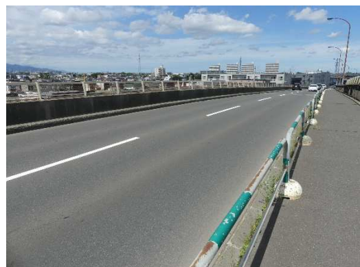
写真-8 補修後状況②
