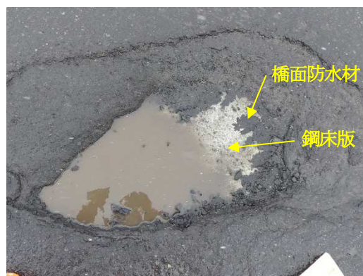
写真-4 鋼床版露出状況
