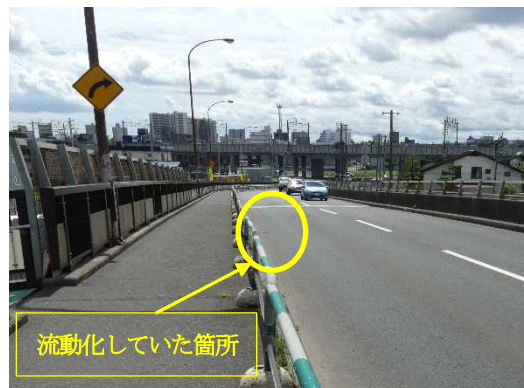
写真-7 補修後状況①
