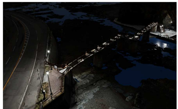
図-9 夜間照明の設置状況を上空から表現
