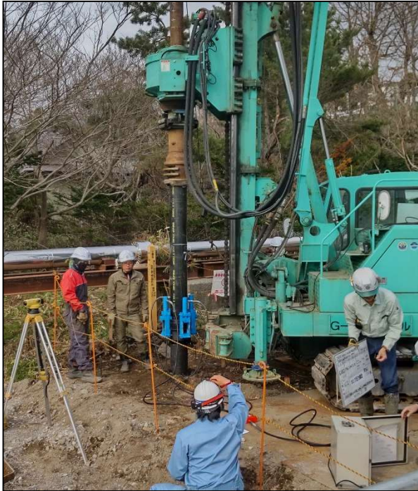
写真-3 G-ECS PILE 工法施工状況
