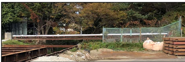
写真-1 既設水管橋
