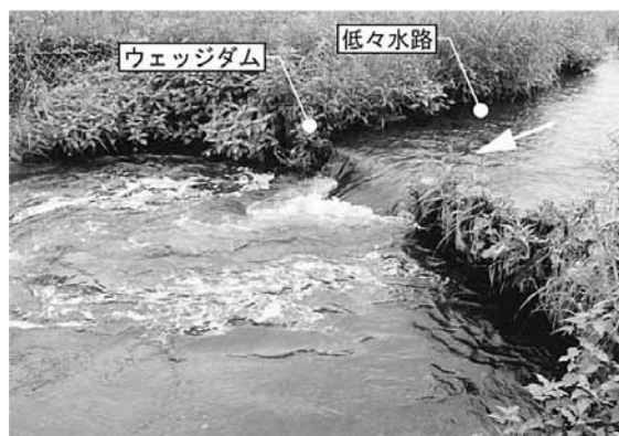
写真4 改修半年後の状況
