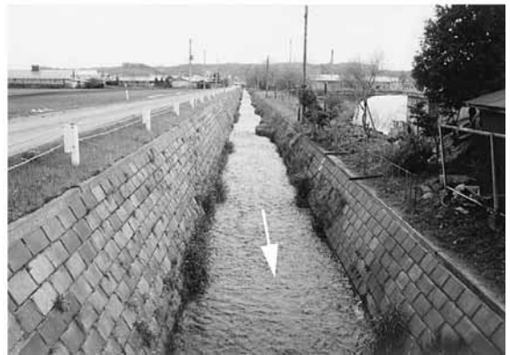
写真1 改修前の状況
