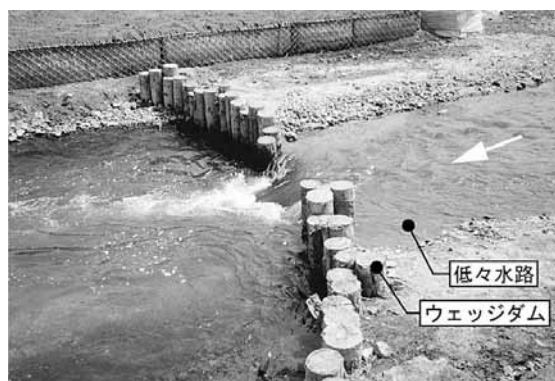
写真3 改修直後の状況
