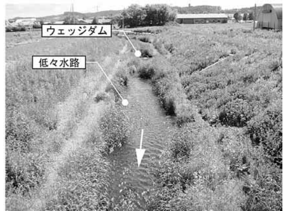
写真2 改修後の状況
